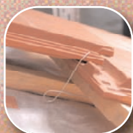
Bevestiging bij bestaand onderdak
