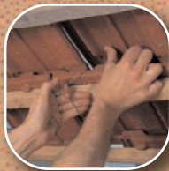
Bevestiging onderaan de dakconstructie
